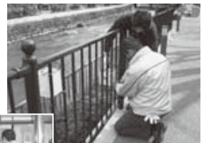
広瀬川イルミネーション 設置作業
