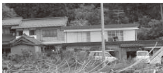
瓦礫を撤去したお宅
